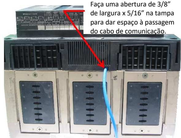
Instalação do cabo de comunicação (abertura na parte superior da tampa do disjuntor) (AC-PRO-MP-II)
